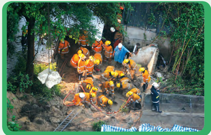
2008年舊咖啡灣山泥傾瀉 – 2人死亡 Cafeteria Old Beach Landslide in 2008 – 2 fatalities
